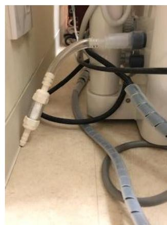
② 診察ユニットからの排気口にフィルターを装着し、診察室内でのエアロゾル感染の対策をしております。
